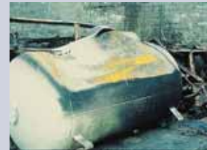
Flüssiggastank mit Riss durch Feueereinwirkung eines brennenden Campingwagens.
