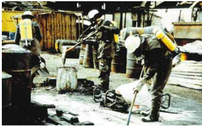
Neutralisationsarbeiten nach einem Austritt organischer Peroxide.
