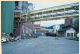
Zerknall eines Stahl tanks bei der Firma Leykam in Gratkorn/Graz.
