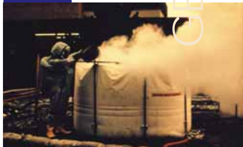
Umfangreiche Neutralisation von Ammoniakwasser im Innsbrucker Olympiastadion im Jahre 1978. 8.300 Liter Schwefelsäure wurden verwendet.
